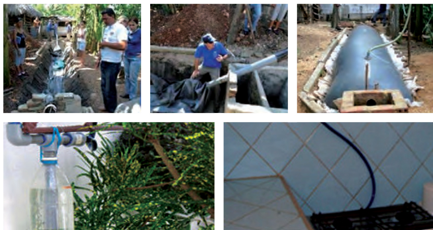
Fig.11. Inicios de la instalación y puesta en marcha del primer biodigestor de geomembrana de PVC construido en Cuba (modelo “CIDELSA”). Fotos tomadas por el autor del trabajo.
