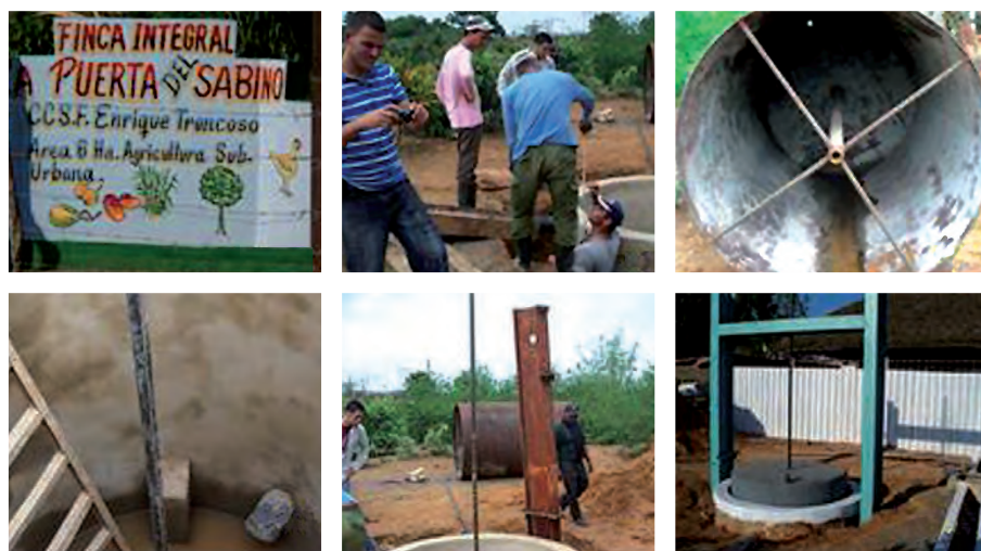
Fig.10. Diferentes etapas de construcción y montaje de un biodigestor de campana flotante.
