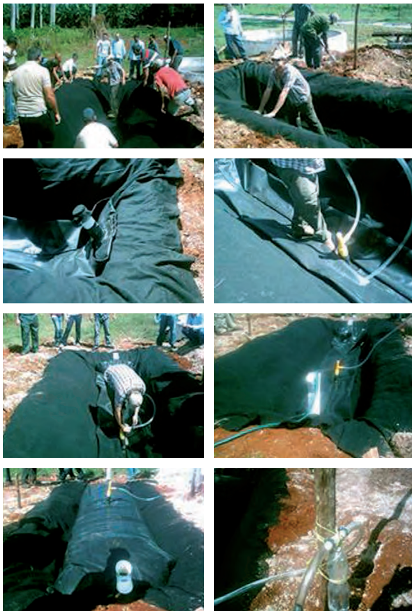
Fig.13. Montaje del primer biodigestor del modelo biobolsa que se instaló en Cuba, como polígono de experimentación. Fotos tomadas por José A. Guardado, durante su participación en el Taller Internacional UNICA 2012 en Morón, Cuba
