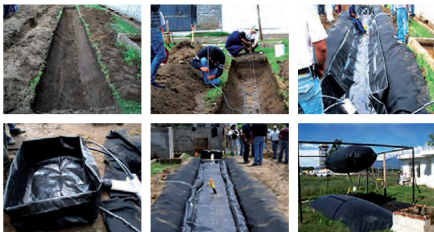
Fig.12. Montaje de un biodigestor del modelo biobolsa. Fotos tomadas por José A. Guardado, durante su participación en el Taller Internacional de Biobolsas en mayo del 2012, México.
