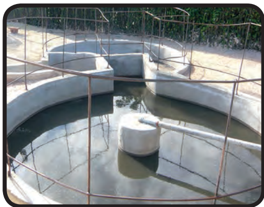
Biodigestor construido ...
